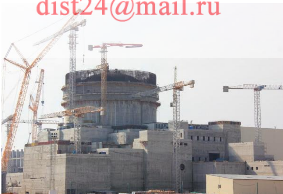
Рисунок 5 - Здание реактора Белорусской АЭС
